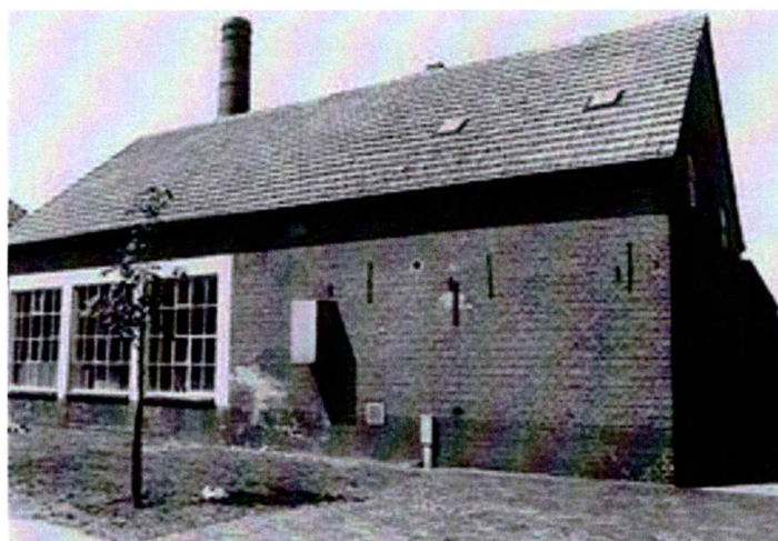
Rombauts Limonadefabriek, gebouwd in 1945/'46
