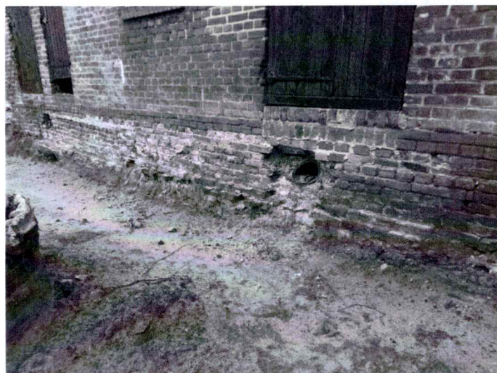
Het wc gebouwtje met links de twee deurtjes van het toilet en de rechtse deur van de schuur. Het is gebouwd op oude bestaande funderingsresten waarschijnlijk nog die van de schuurkerk.
